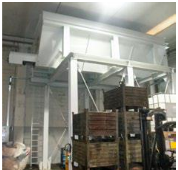
Silos horizontaux équipés de capteurs de pesage
