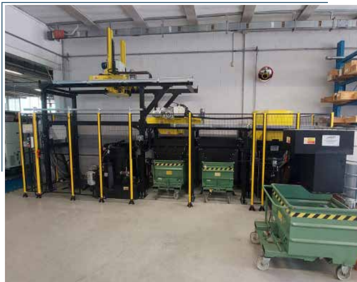
Système avec trois stations de déchargement pour acier, laiton et inox
