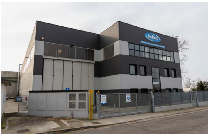
Stabilimento di Montirone - BS
