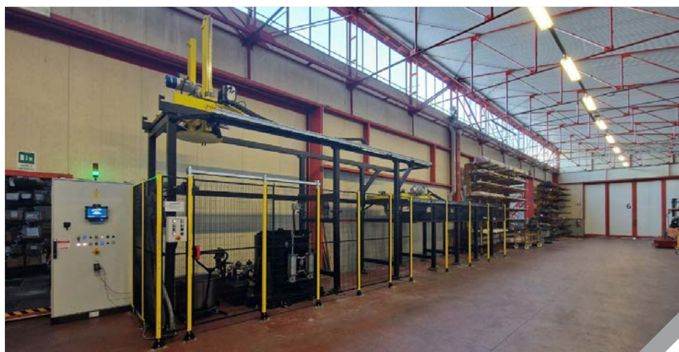
Impianto con quattro stazioni di scarico
