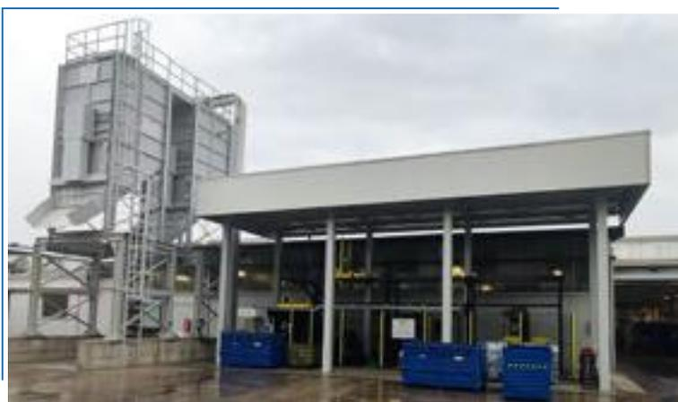
**Due stazioni di carico, centrifugazione, triturazione e insilaggio di ottone ed alluminio**
