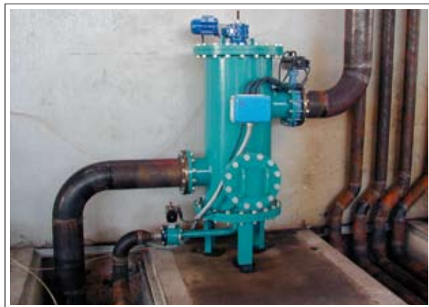
filtro autopulente portata 5000 lt/min grado di filtrazione 30 micron
